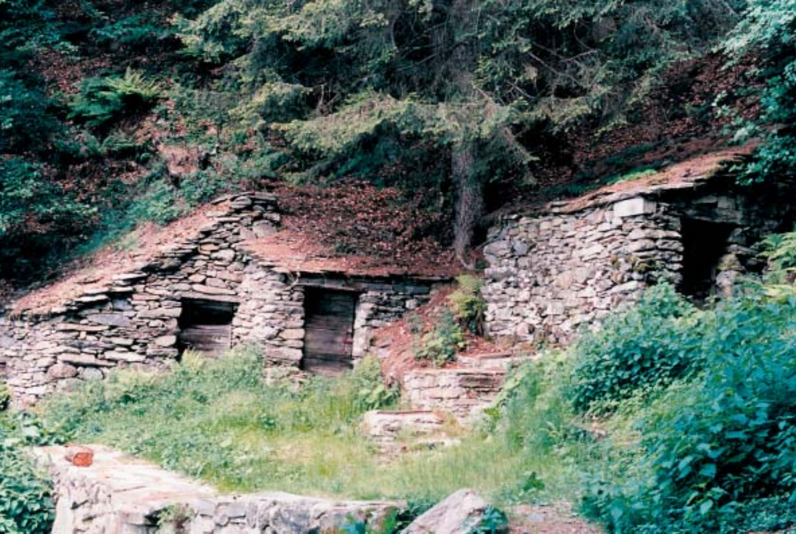
Büdelere (caselli del latte) costruiti in prossimità di torrenti o ruscelli, in passato queste strutture erano impiegate per la conservazione del latte e del burro
